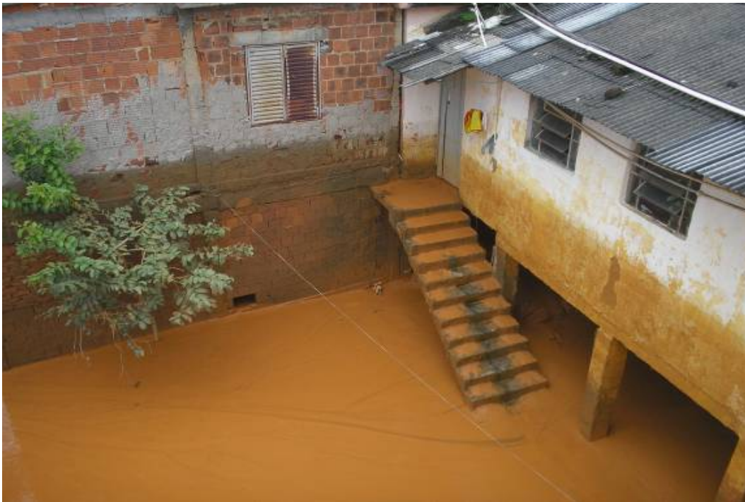
Foto 7 – Quintal de casa ribeirinha em que se observa que o nível da água foi bastante alto pela marca nas paredes.
