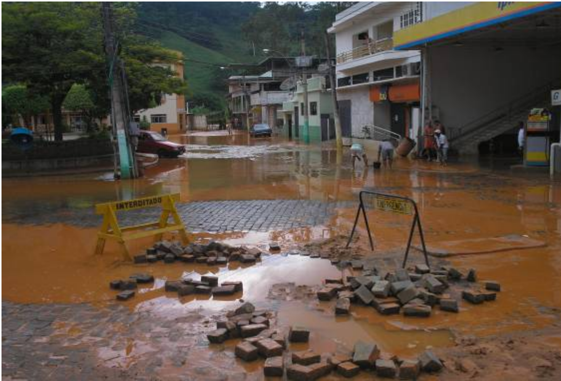
Foto 4 – Situação do centro da cidade imediatamente após a passagem da mancha de rejeitos de bauxita.
