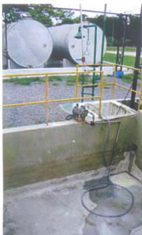
Local exato do vazamento
